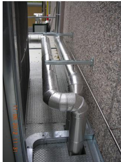
Tubazioni alimentazione da gruppo frigo
