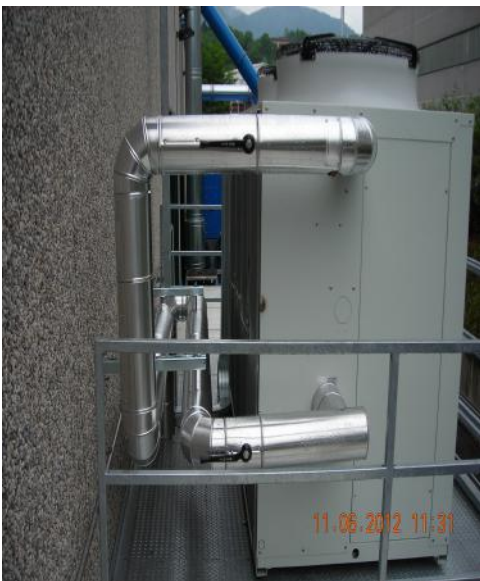
Tubazioni alimentazione da gruppo frigo
