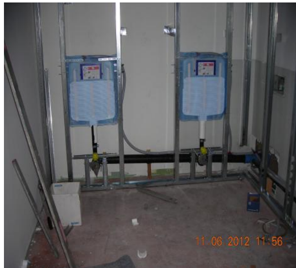
Impianti sottotraccia
